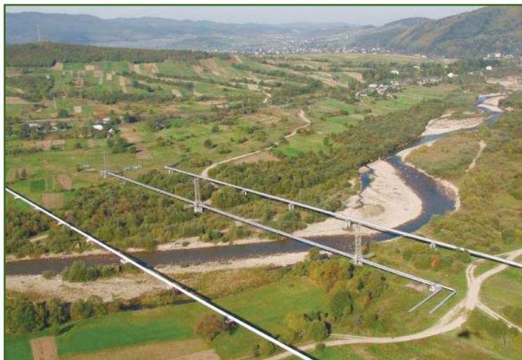
Рис. 1 Надземные переходы магистральных газопроводов через р. Стрый
