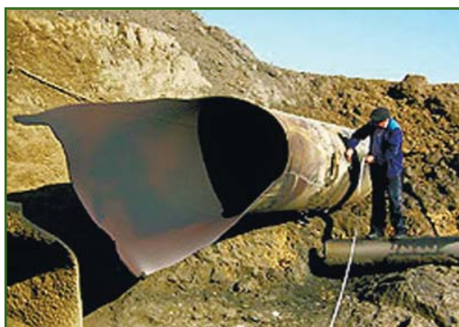
Рис. 2 Последствия разрыва трубопровода
