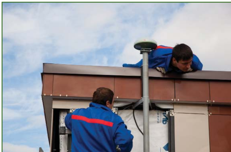
Рис. 1 Проведение работ по установке антенны референцной станции
