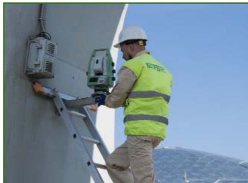
Монтаж системы мониторинга деформаций в парке «Зарядье»
