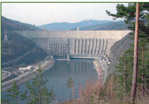
Рис. 1 Общий вид плотины Саяно-Шушенской ГЭС
