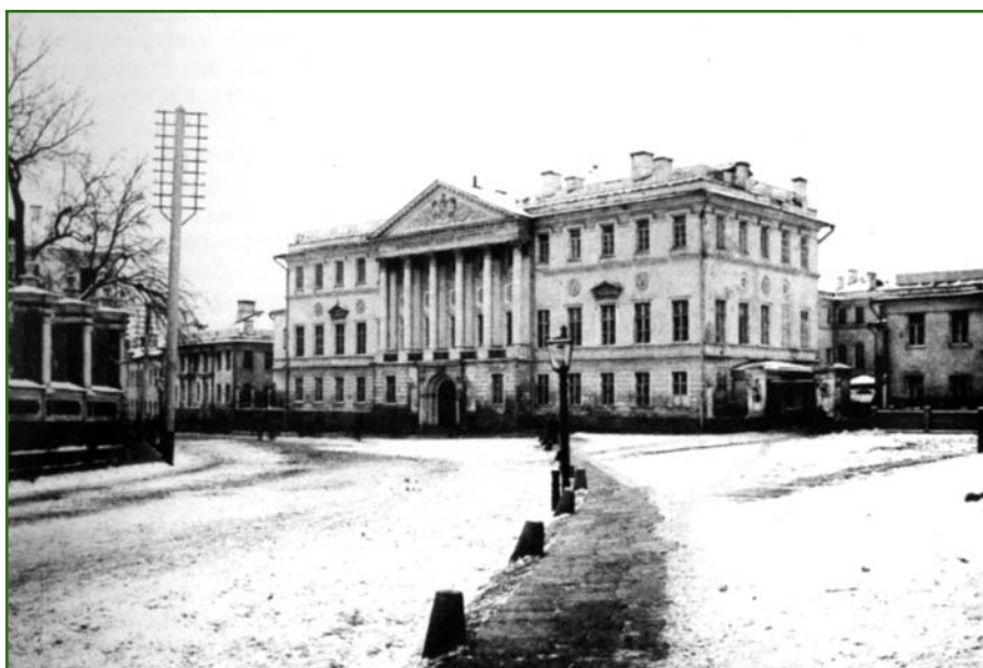
Здание Константиновского межевого института в 1880-х гг.
