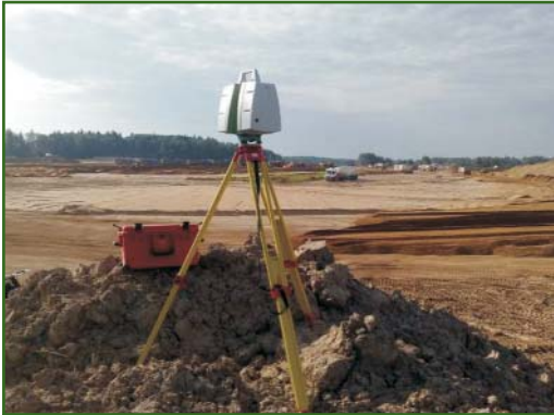
Рис. 2 ScanStation C10 на объекте
