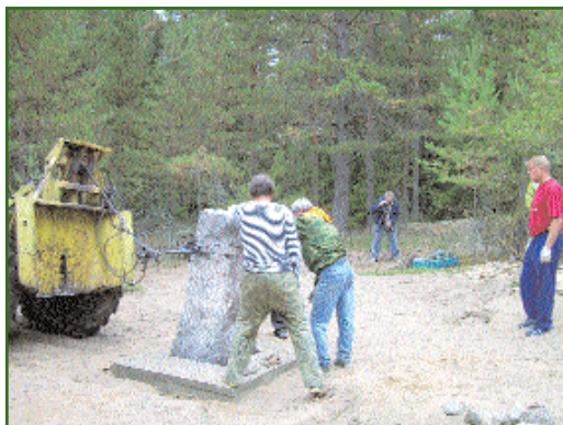
Рис. 2 Установка астрономического гранитного столба
