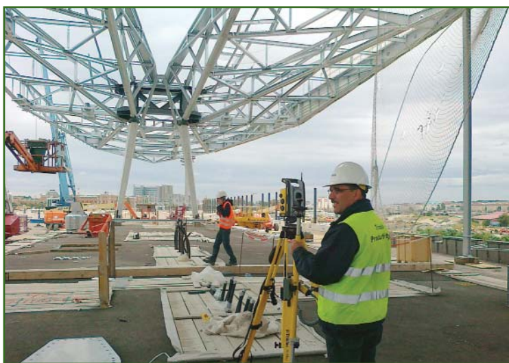
Рис. 6 Контроль монтажа сборки ферм кровли с помощью роботизированного тахеометра Trimble
