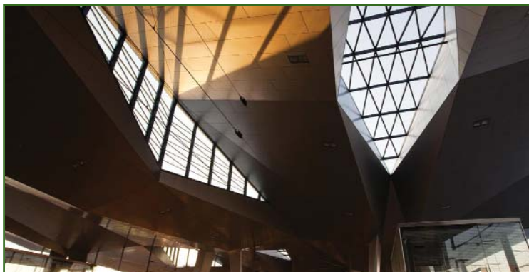
Рис. 2 Внешний вид кровли с железнодорожной платформы
