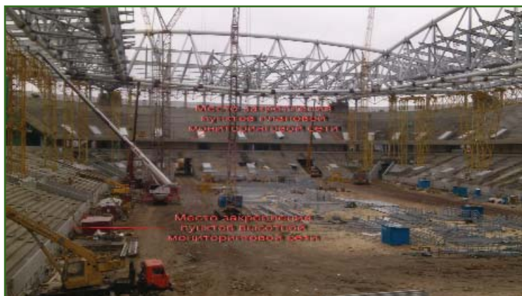
Рис. 2 Места закрепления пунктов мониторинговых сетей на объекте
