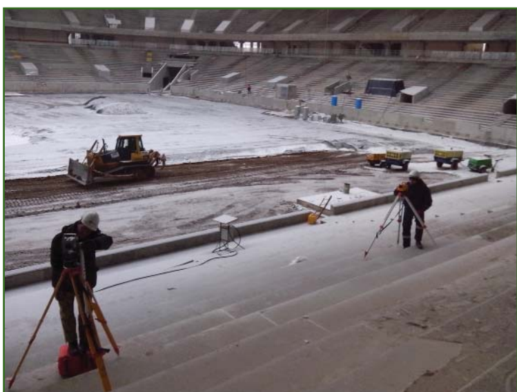
Рис. 6 Передача отметки на ось вращения зрительной трубы тахеометра
