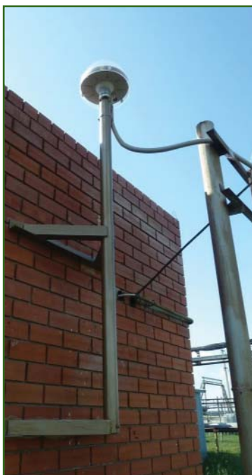
Рис. 4 Базовая станция ГНСС на нефтяном месторождении
