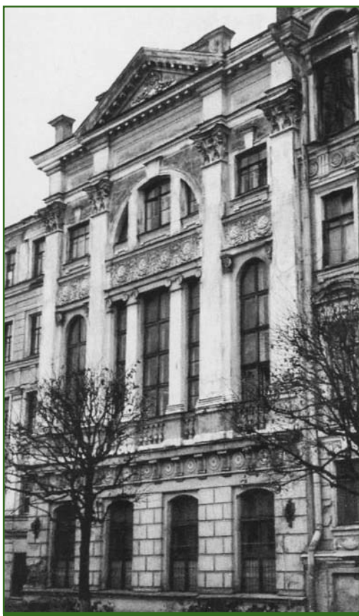
Здание бывшего Военно-топографического училища, в котором расположена экспозиция музея ( http://pastvu.com )
